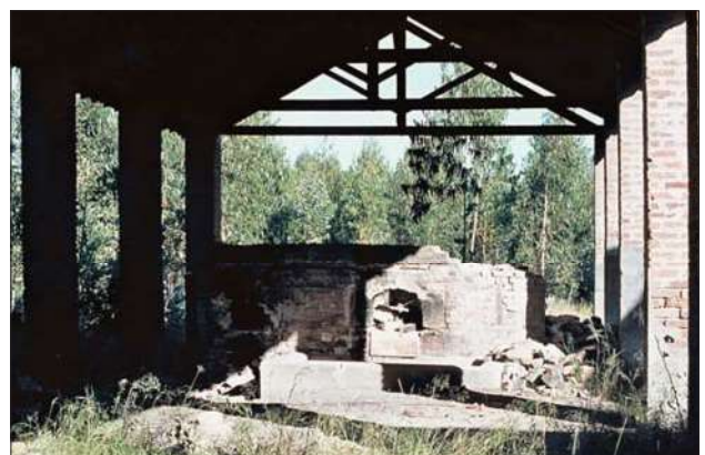
FIGS. 8 E 9 – Forno da olaria em 1977. Aspeto exterior e interior. Arquivo Iberonorma.
