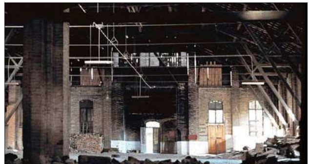
FIGS. 6 E 7 – Edifício principal em 1977. Aspeto exterior e interior. Arquivo Iberonorma.
