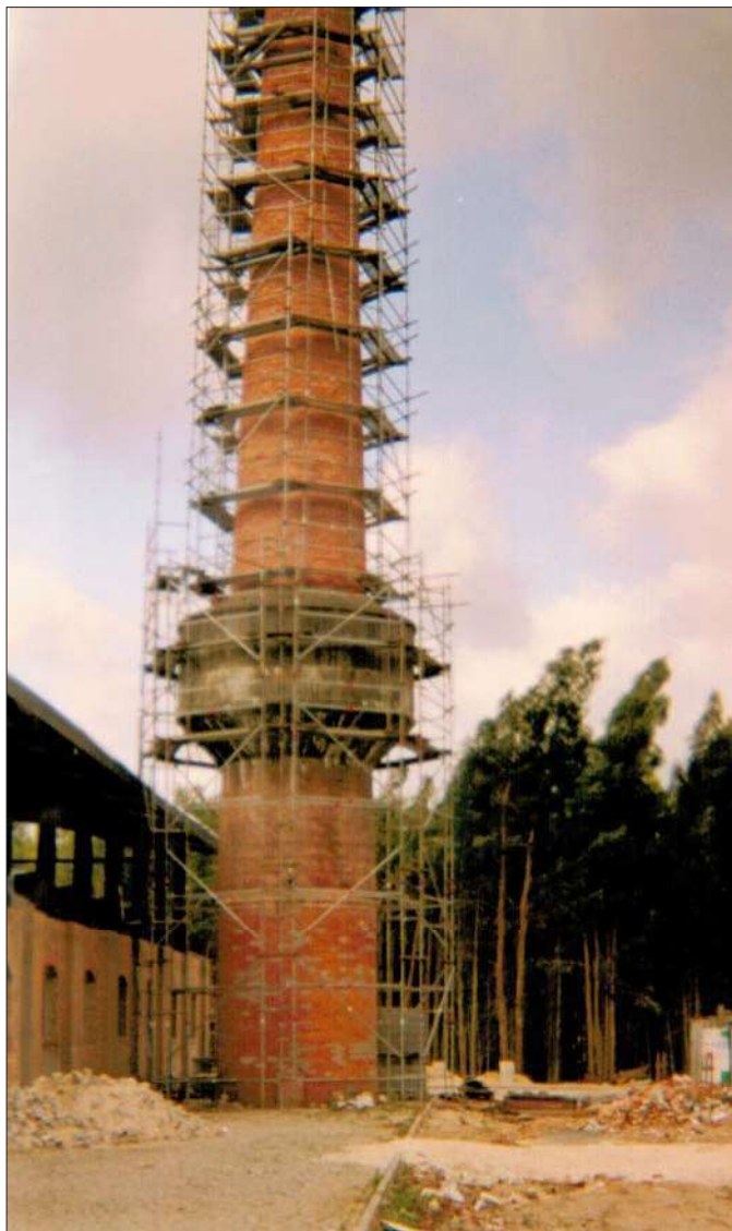
FIG. 14 – Demolição da chaminé, Arquivo Iberonorma, 2000.
